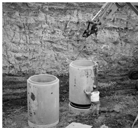
Traditionella metoder kräver omfattande schaktarbete som stör trafik, påverkar gatumiljön, innebär höga kostnader och kräver mycket arbetsresurser.
